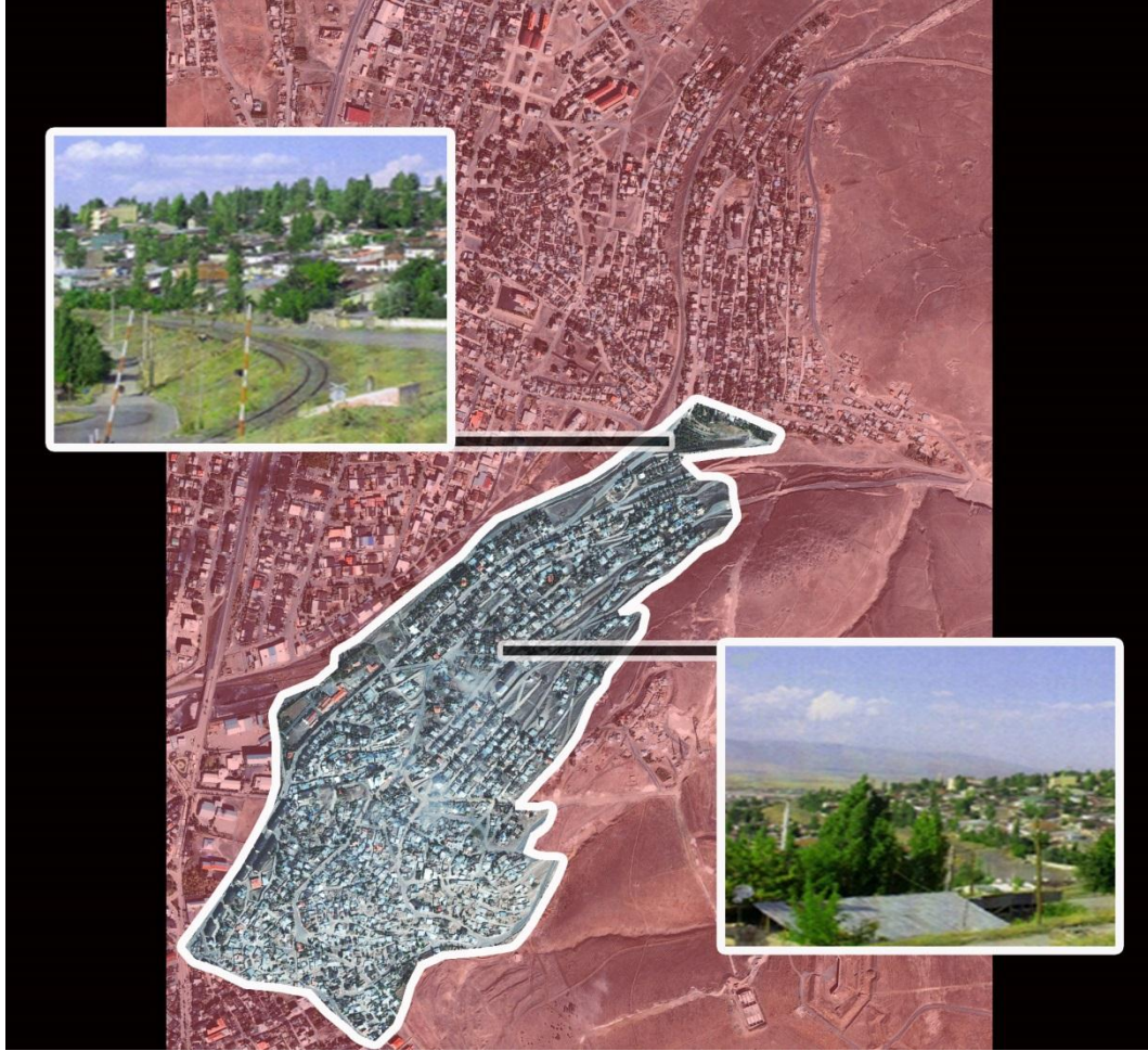
Şekil 2. Dağ Mahallesi'nin genel görüntüsü (fotoğraflar: Demircan, 2010).
